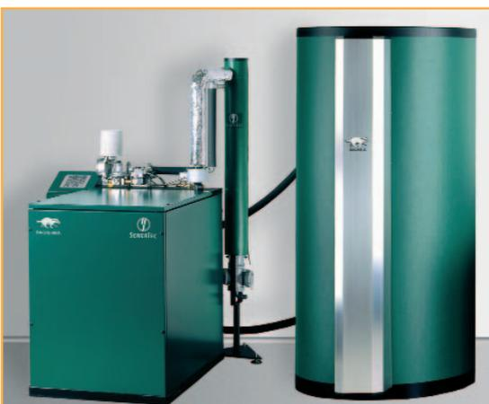
Die Kraft-Wärme-Kopplung (KWK), bei der gleichzeitig elektrischer Strom und Wärme produziert werden, nutzt den Energieträger besonders gut aus. Blockheizkraftwerke haben sich bereits vielfach in mittleren Wohnanlagen bewährt. Und seit kurzem gibt es zuverlässige Geräte selbst für große Einfamilienhäuser.
